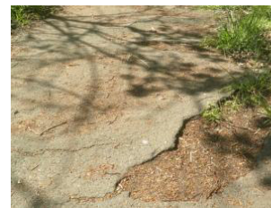
durch Wurzeln aufgebrochene Decke
