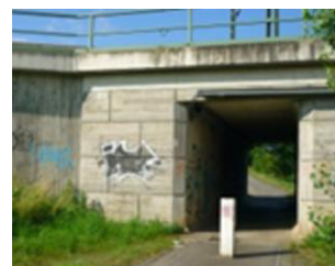
Gefahrenstelle Mulderadweg im Abschnitt Glauchau Quelle: LRA Zwickau
