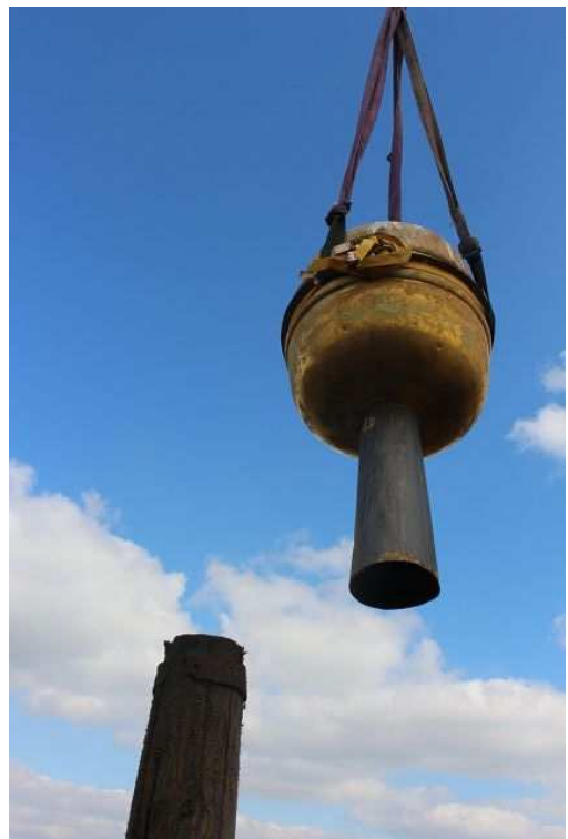
Sicherstellung der Turmspitzen
