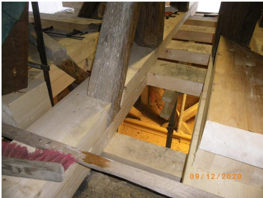
Decke Turmhaube nach Sanierung
