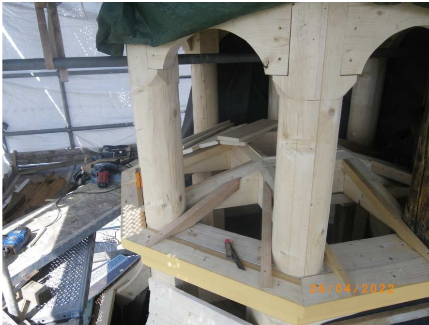
Oberer Turmhelm nach Sanierung
