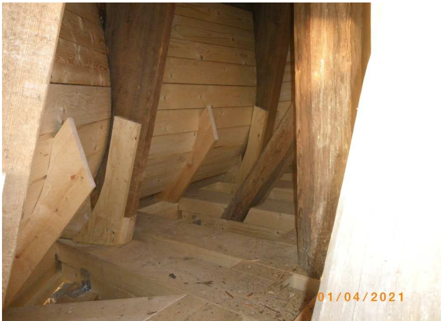
Neue Schalung im Bereich der Turmhaube und gesicherte bzw. neue Schweißsparren im Bereich Turmhaube
