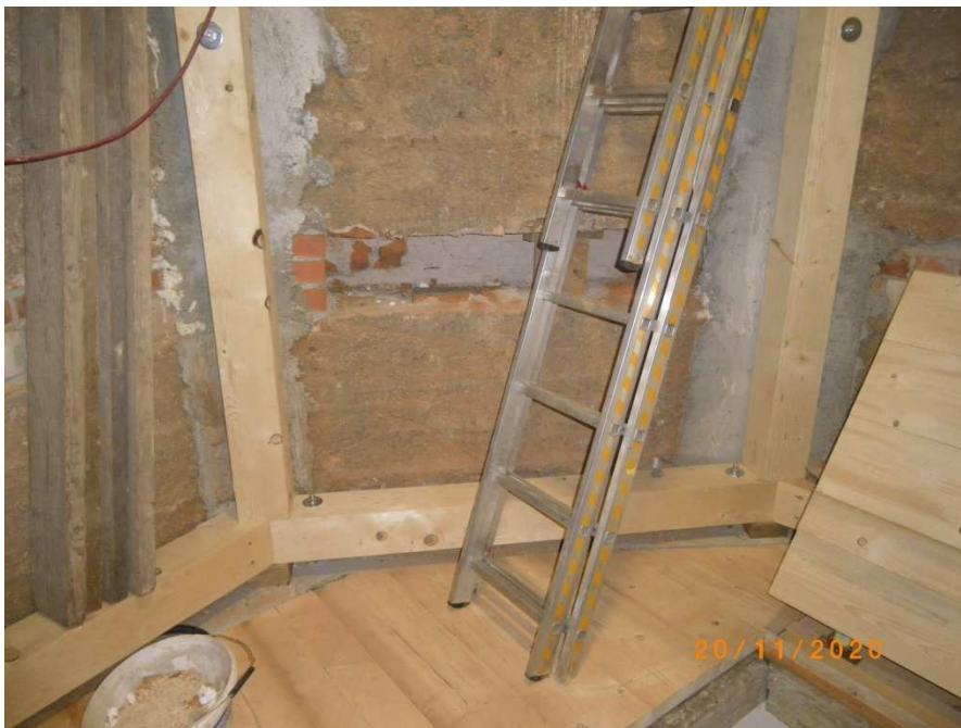
Ausbetonierte Eckstützen und neue Holzeckstützen
