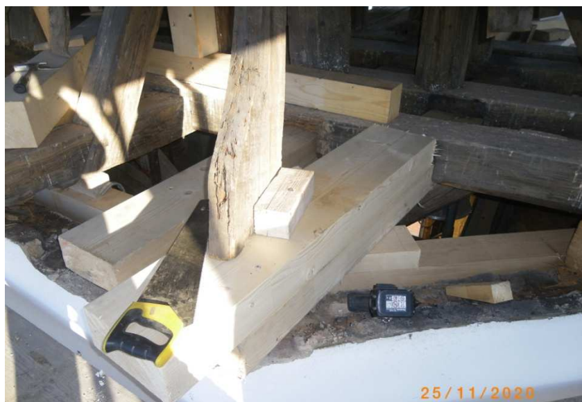
Auswechslungen im Bereich der Decke und der Dachkonstruktion der Turmhaube
