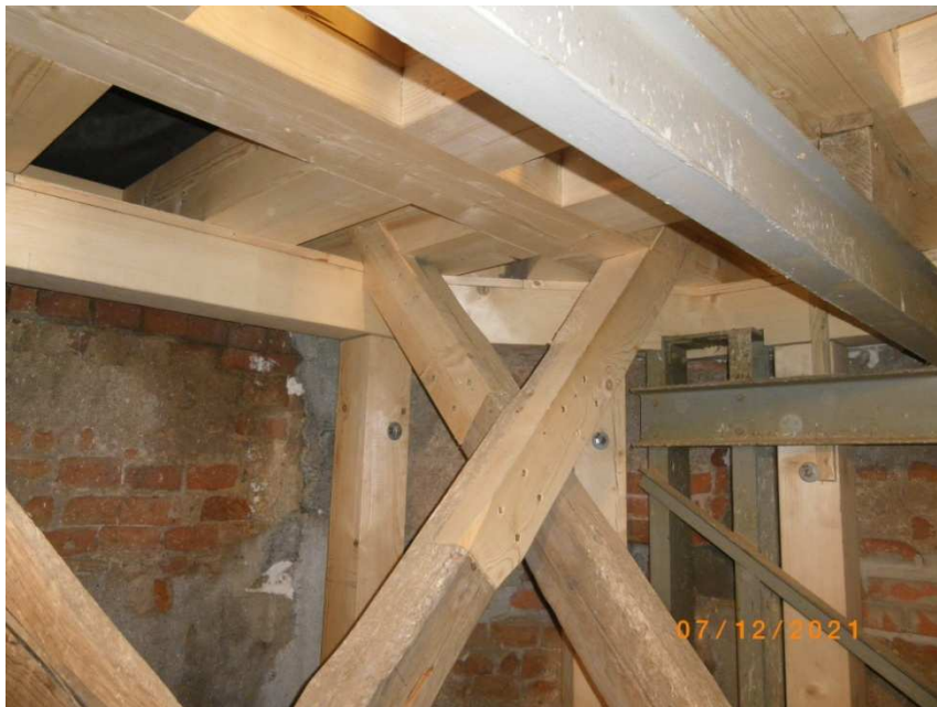
Erneuerte Tragkonstruktion der Turmhaube
