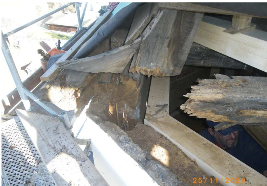
Angegriffene Sparren Turmhaube
