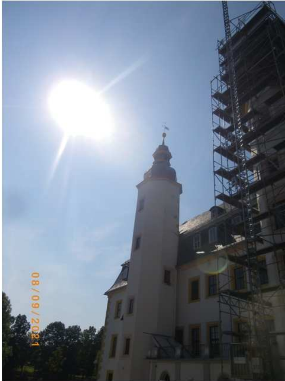
5: 20210908_IMG2315 Gerüst Nordtum
