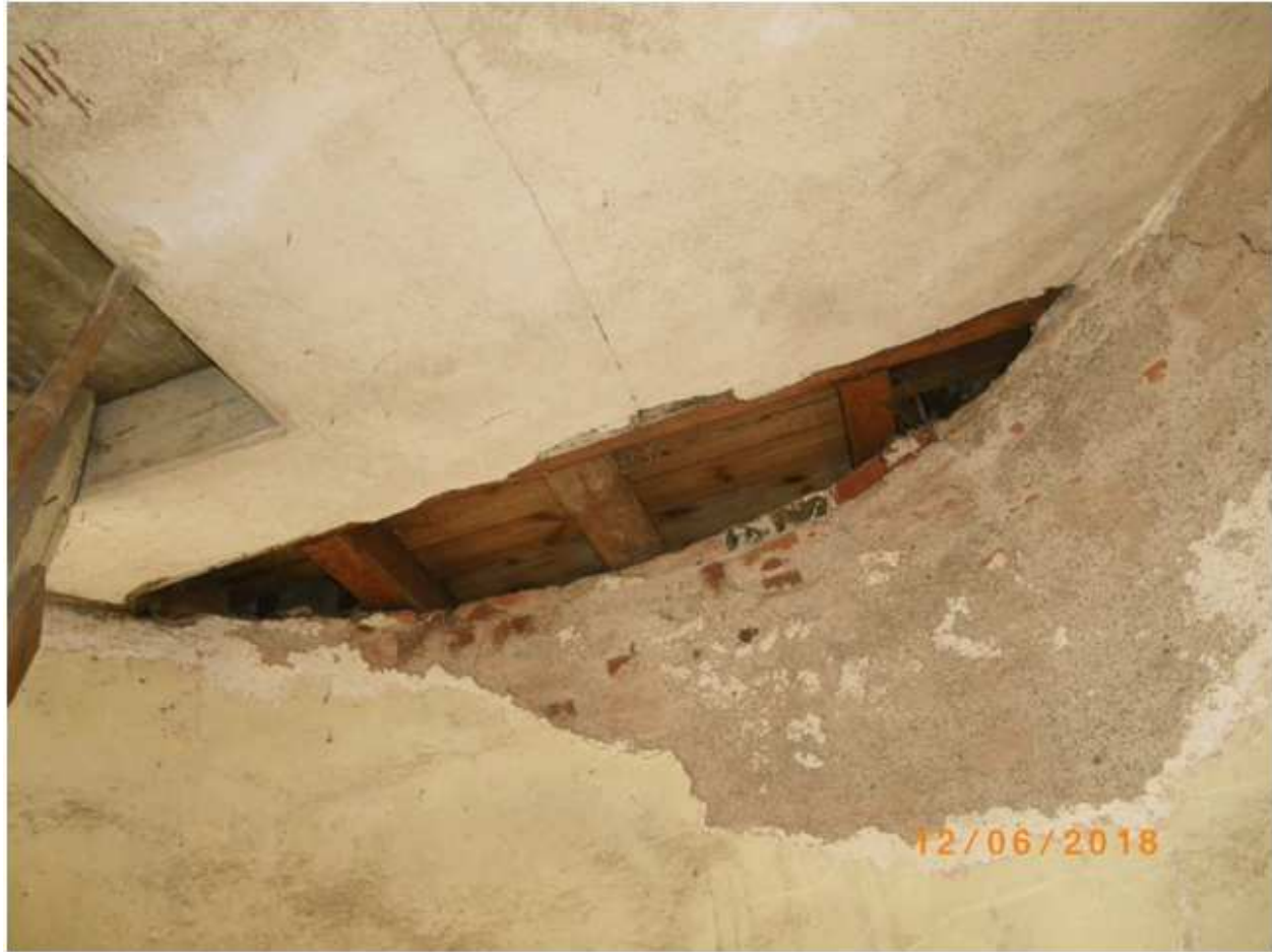
2: 2018_02 sichtbare Holzkonstruktion zeigt keinerlei Schäden
