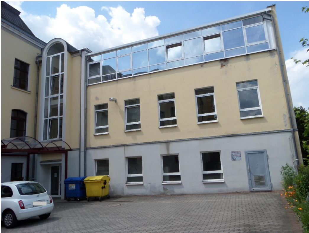
Hofansicht Neubau, Cafeteria im 2. OG mit Verglasung der Fassade
