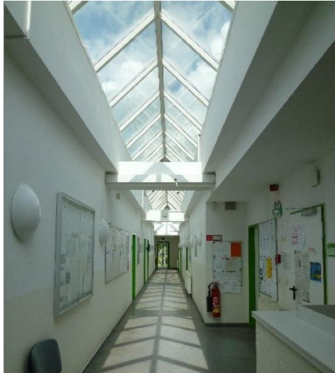
Flur Obergeschoss Kopfbau
