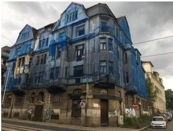
Bild 1: Gründerzeitliches Wohnquartier in Zwickau (eigene Aufnahme, 28.07.2017)
