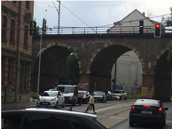
Bild 3: Verkehrsinfrastruktur Zwickau (eigene Aufnahme, 28.07.2017)
