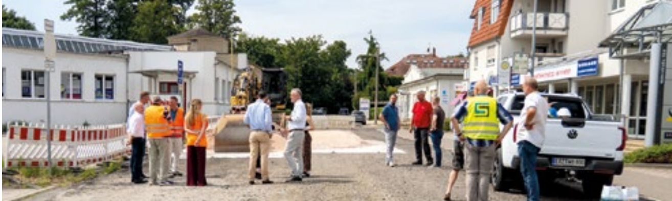
Auf einer Länge von 535 Metern wird die Wehrstraße in Glauchau umfassend saniert.
