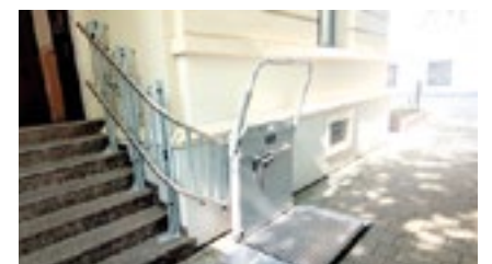
Rollstuhl-Schrägaufzug in der Praxisgemeinschaft Weinkellerstraße in Hohenstein-Ernstthal Foto: Dr. Grünert
