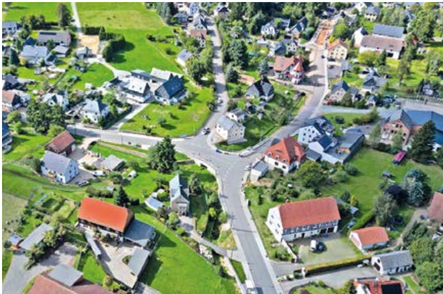
Die Kreisstraßen in der Gemeinde Mülsen werden weiter schrittweise erneuert.
