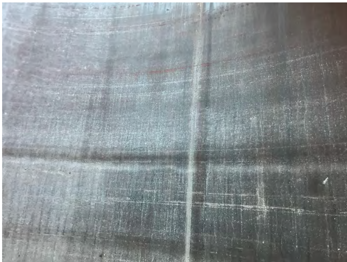
Innenansicht, Wandbereich, obere Hälfte
